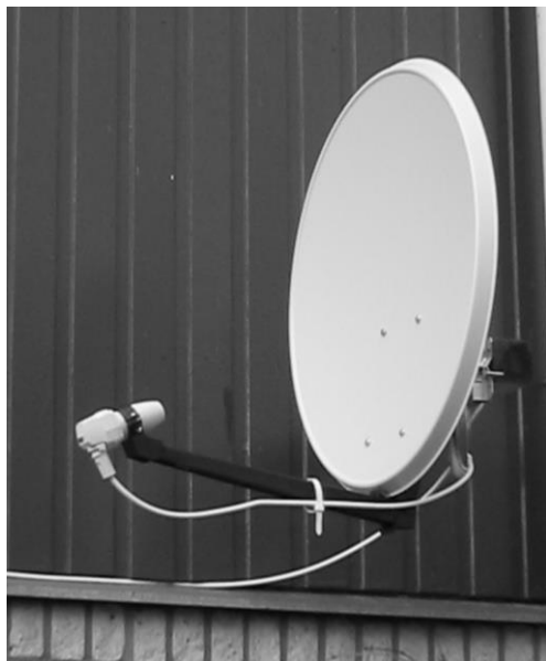
Рис. 4.1. Параболічна дзеркальна антена
