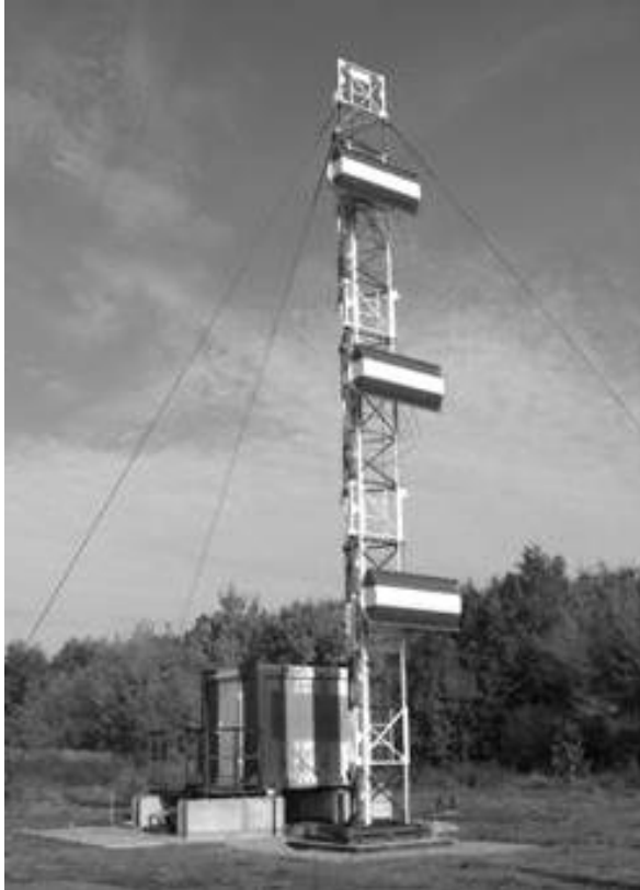
Рис. 5.1. Циліндро-параболічні антени глісадного радіомаяка
